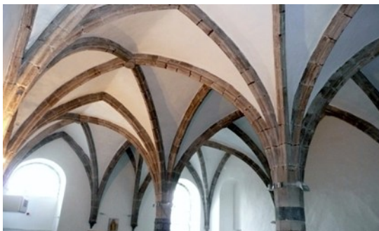
Voûte de la cuisine du XIII e siècle
